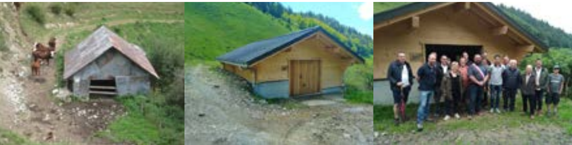
Inauguration le 6 juillet 2024 de l’Ecurie ARPEYRON, dont les travaux de rénovation ont été portés par l’AFP du Mont-Charvin
